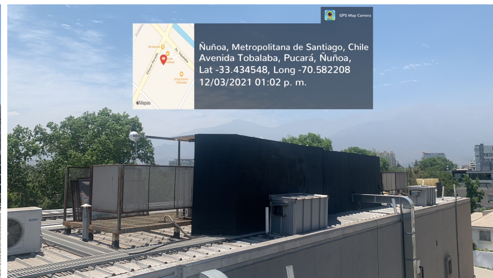
Barreras Acústicas Equipos de Aire Acondicionado y Extractores de las fuentes de diversos locales - Sector Techumbre Piso Superior
