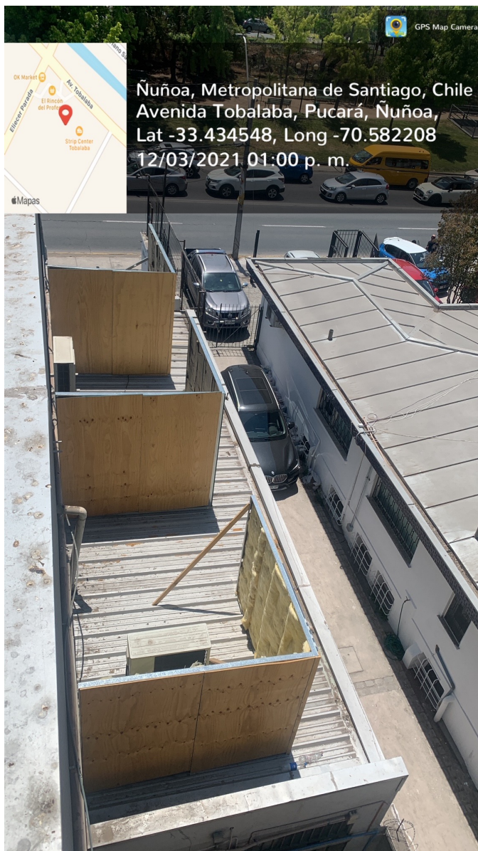
Barreras Acústicas Equipos Extracción Profesor Klocker
