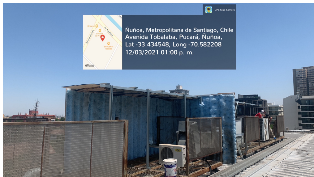
Barreras Acústicas Equipos de Aire Acondicionado y Extractores de las fuentes de diversos locales - Sector Techumbre Piso Superior
