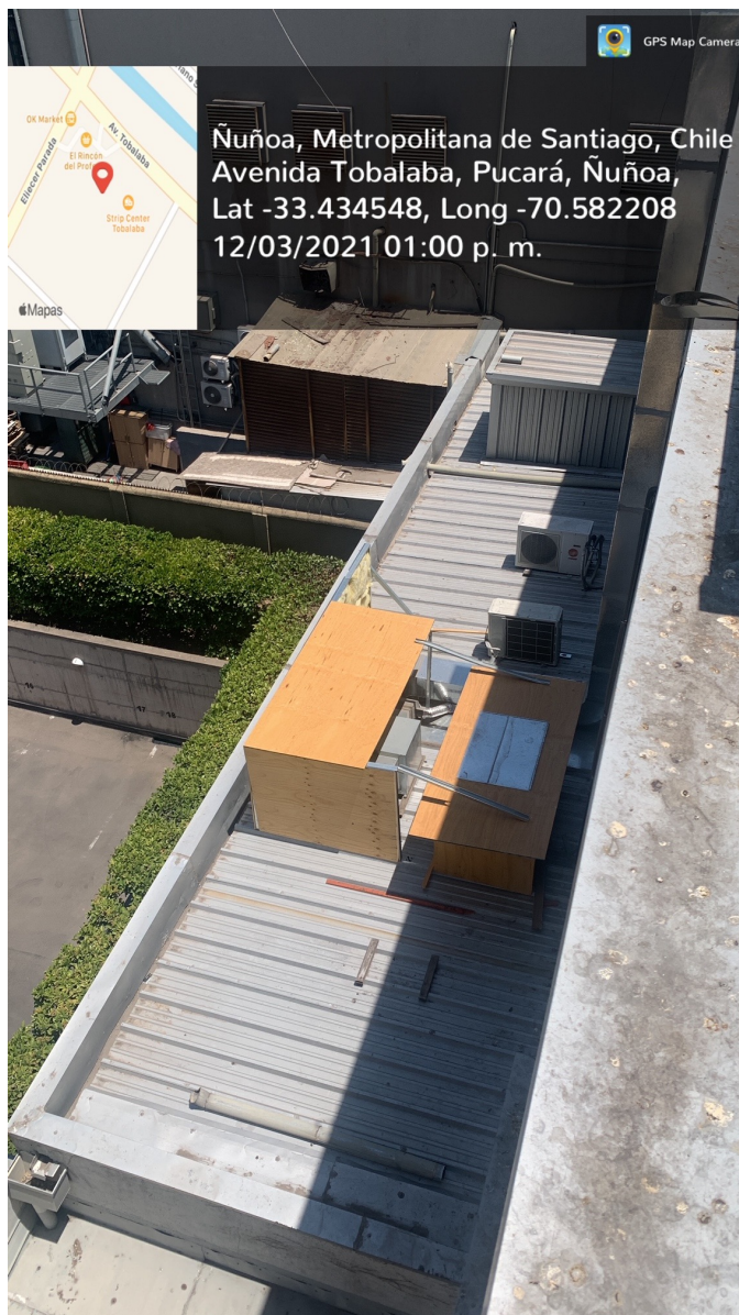
Barreras Acústicas Equipos Extracción Niu Sushi
